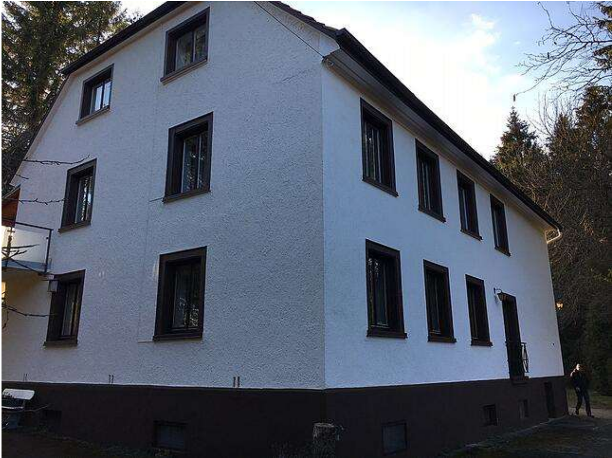
Das Elternhaus von Fritz Reimnitz beim Posthaus befindet sich im Besitz der Stiftung. | Bild: Micha Bächle
